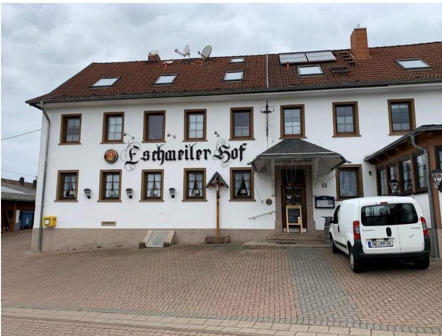
Abbildung 8: Gasthaus „Eschweiler Hof“
