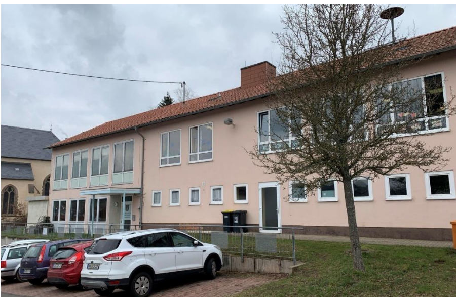
Abbildung 37: Ehemaliges Schulgebäude in Hangard
