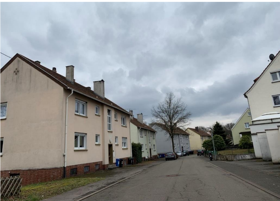
Abbildung 44: Mehrfamilienhäuser im südlichen Siedlungsteil Heinitz'
