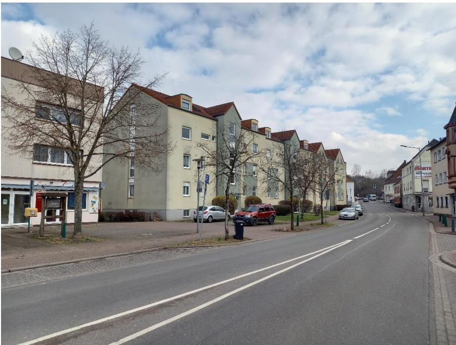
Abbildung 116: Mehrfamilienhausbebauung in der Haupteerschließung Homburger Straße
