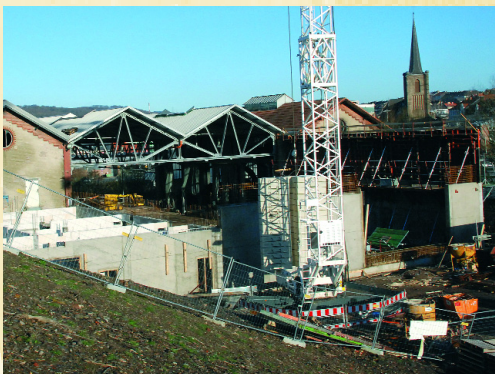
Gebläsehalle im Umbau, Januar 2012
