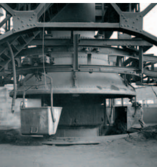
Befüllung des Hochofens auf der Gichtbühne
