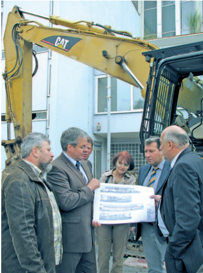
OB Decker prüft den Plan für den Neubau am Mantes-la-Ville-Platz
