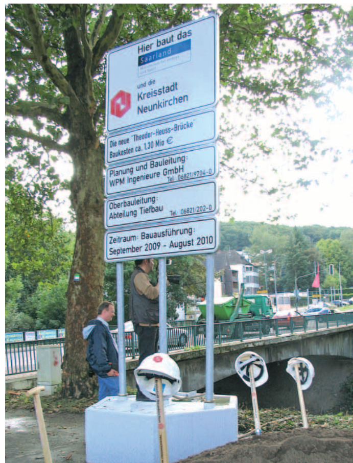
Die neue Brücke entsteht direkt neben der alten.
