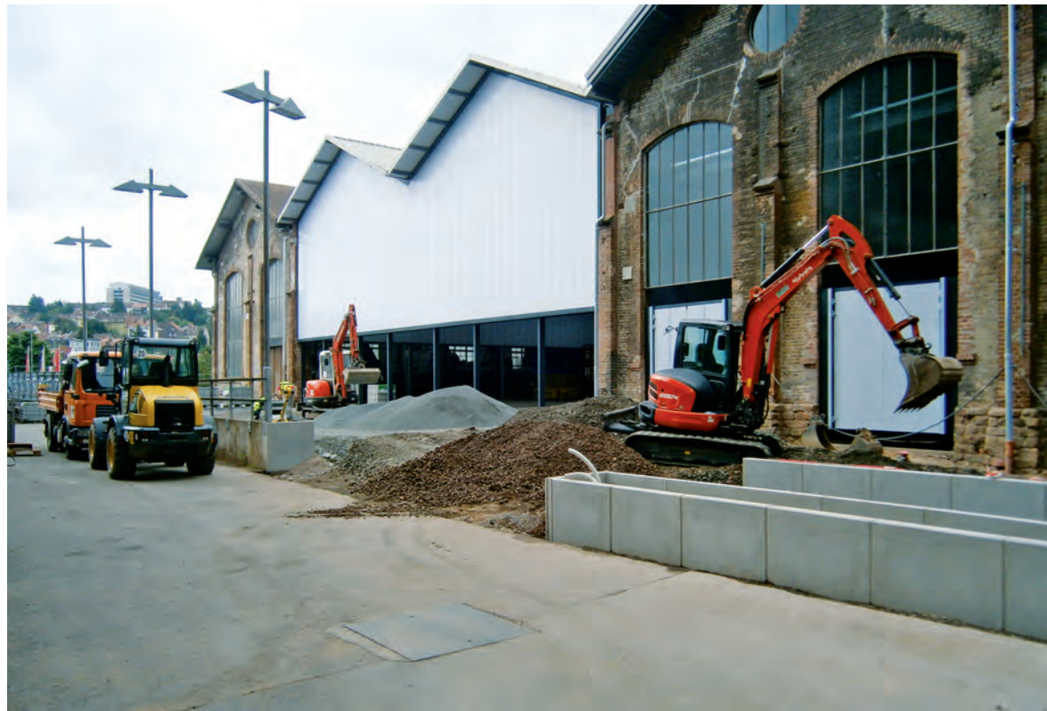
Baggern für die neue Fassade der Gebläsehalle
