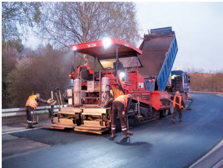
Deckensanierung Industriegebiet „Am Ochsenwald“ 2014 Foto: Stadt NK
