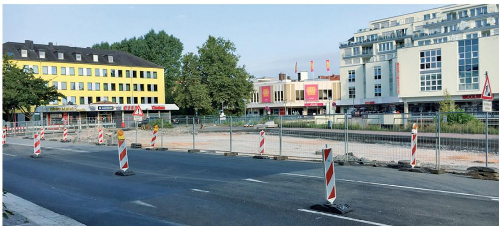
In der Lindenallee wird der Asphalt für den zweiten Bauabschnitt abgefräst.
