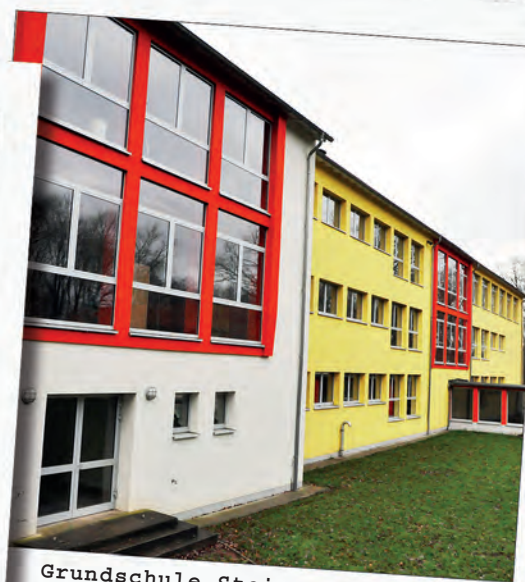
Grundschule Steinwald: Neue Klassenräume werden angebaut
