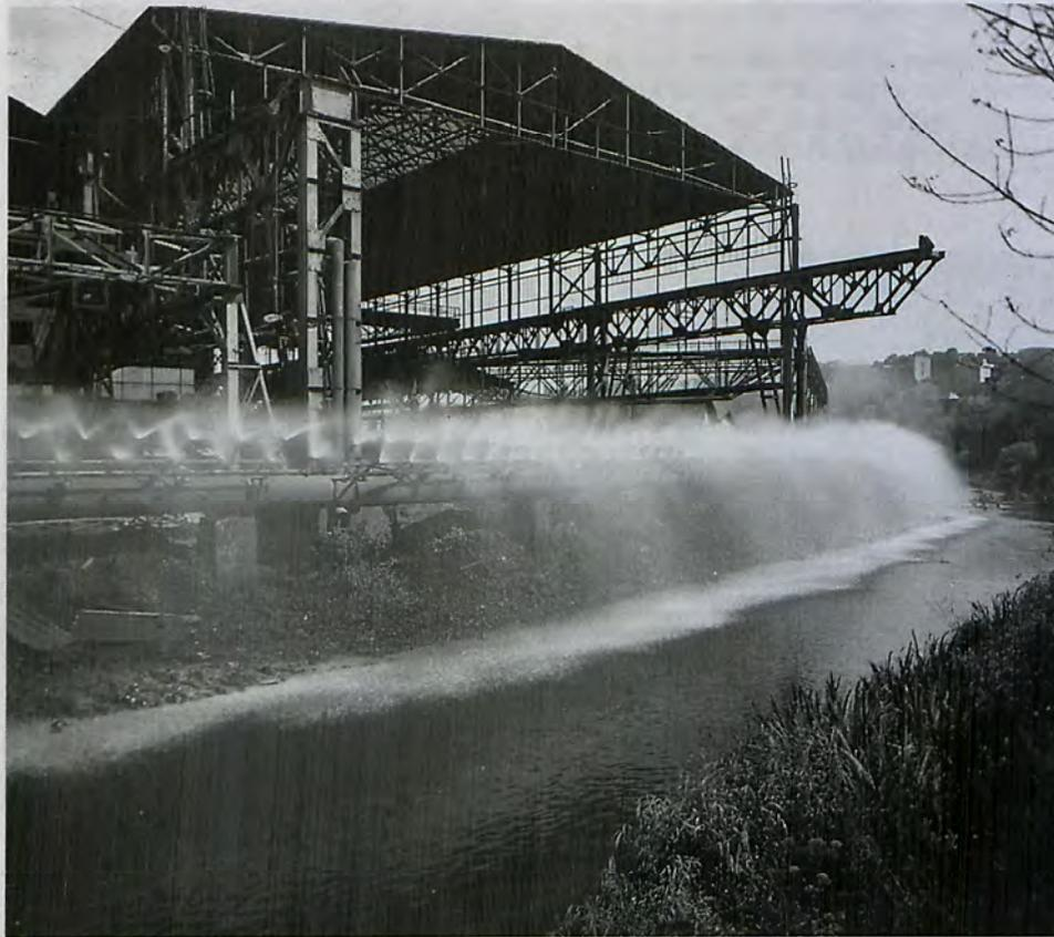
Wasserkühlung durch Versprühung über dem Vorfluter. So wie hier an der Blies wurde auch über dem Parkweiher das Rücklaufwasser versprüht und so gekühlt.
