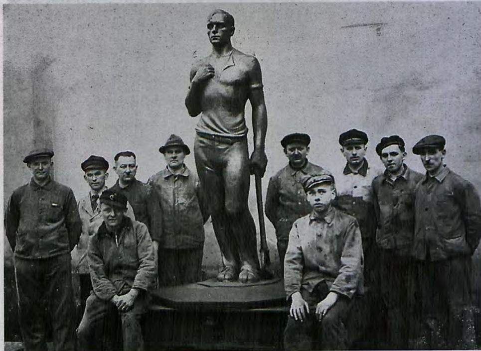
**Der „Walzer“ von Hans Bogler mit den Männern, die ihn einformten, die Form präparierten, das Gußeisen schmolzen und endlich den Guß durchführten. Von Sand und Gießbrückständen gereinigt, sauber geputzt und mit einem ersten Anstrich versehen, steht er hier zum Abtransport bereit.**
