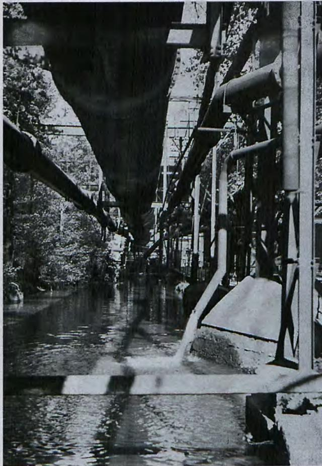
Ein „idyllischer“ Abschnitt des Hammergrabens (um 1935). Vom Parkweiher bis zum Blockwalzwerk war der Hammergraben seit etwa 1910 von der Gichtgasleitung zu den Tieföfen überbaut.
