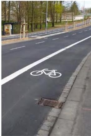
Radfahrstreifen sind durch Zeichen 295 StVO (Breitstrich) abgetrennte Sonderfahrstreifen. Sie sind für den Radverkehr benutzungspflichtig. Der Radfahrstreifen darf vom Kraftverkehr in Fahrtrichtung nicht befahren werden, er darf jedoch zum Ein – und Abbiegen sowie zum Erreichen von Parkständen überquert werden. Andere Verkehrsteilnehmer dürfen ihn nicht benutzen.
