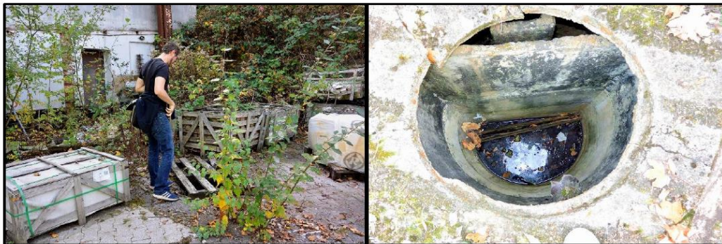
Abb. 10: Fotocluster: links: dürrig abgedeckter Schacht, rechts: Blick von Oben in den Schacht.
