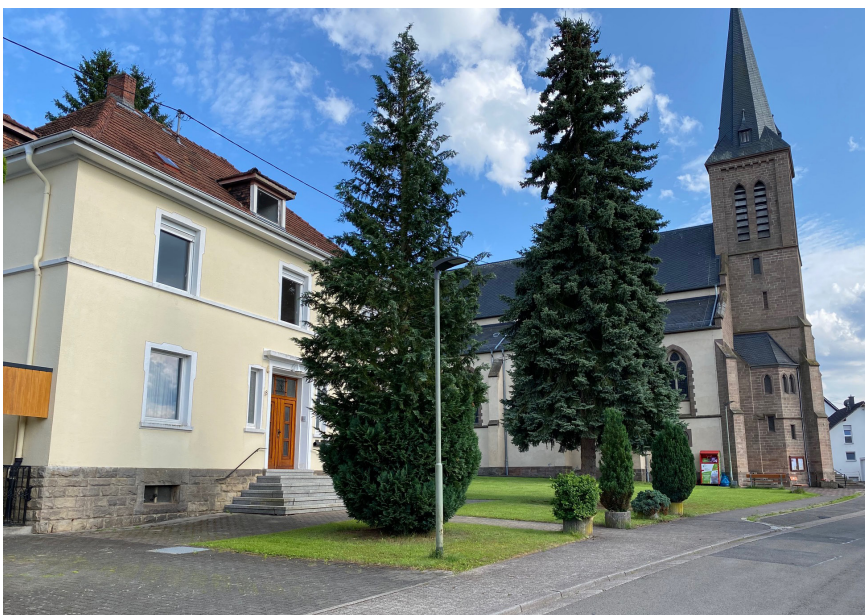
Blick von Nordwesten in das Plangebiet mit Pfarramt links und Kirche rechts im Bild
