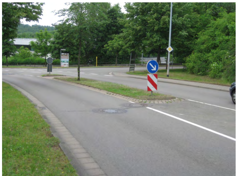
Königsbahnstraße - Blickrichtung Saarbrücker Straße
