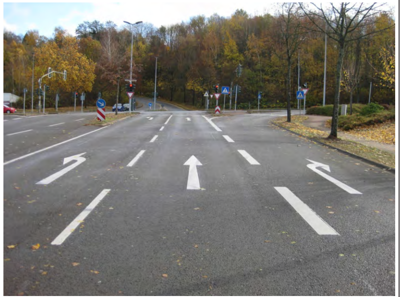
Königsbahnstraße - Zufahrt West
