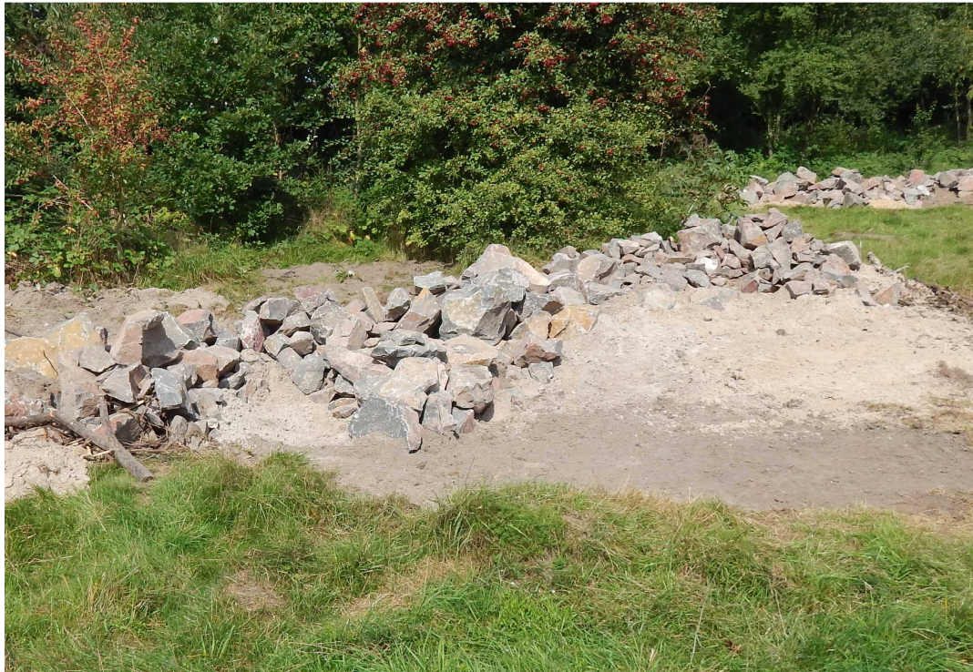
Abb. 8: Beispiel für die Anlage eines Steinriegels.
