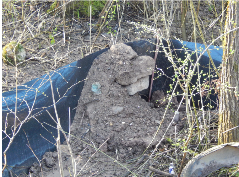
Abb. 5: Beispiel einer Überstiegshilfe für Reptilien mittels einseitig aufgefülltem Erdhaufen.
