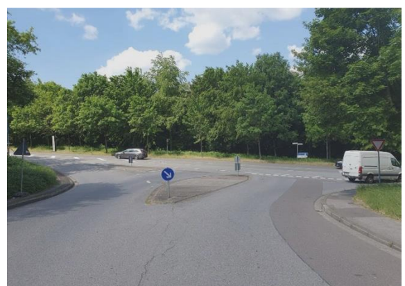
Knoten K3 – Blickrichtung neue Anbindung
