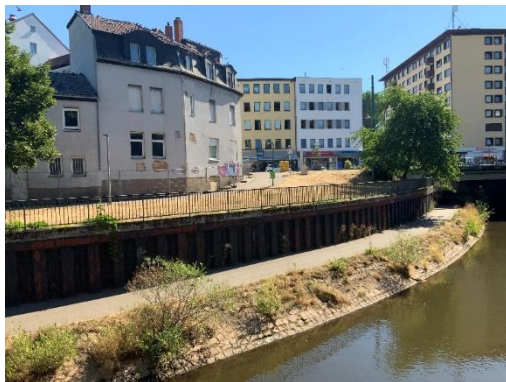
Abb. 1: Gewässer Blies, links Bestandsgebäude mit Spundwand, Hintergrund Bahnhofstr., Situation 2022, Blick in Fließrichtung
