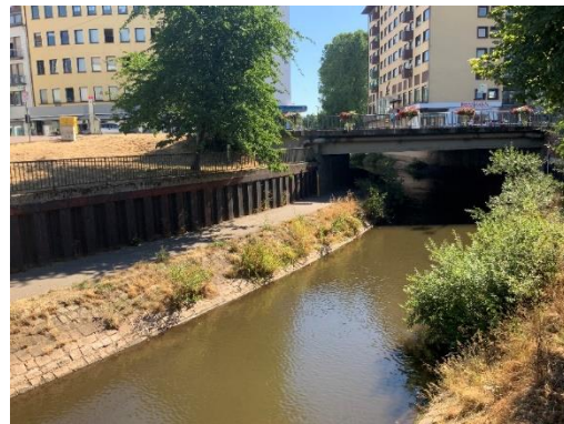
Abb. 2: Gewässer Blies, Spundwand und Brücke Bahnhofstr., Situation 2022, Blick in Fließrichtung
