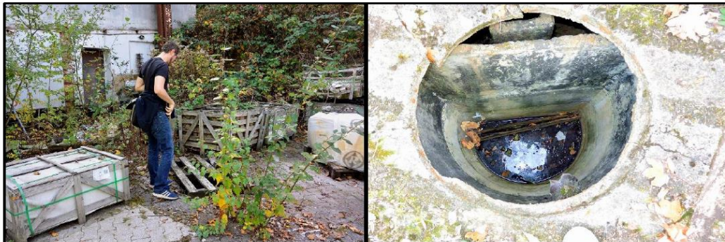
Abb. 10: Fotocluster: links: dürrftig abgedeckter Schacht, rechts: Blick von Oben in den Schacht.
