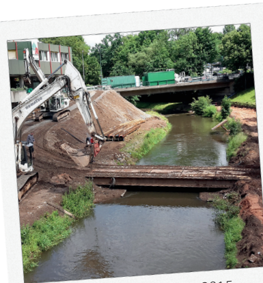
Erste Arbeiten im Sommer 2015
