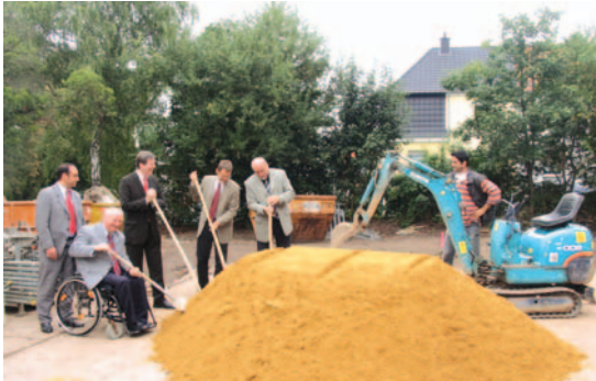
Offizieller Spatenstich: Bei der Feuerwache wird eine neue Rettungswache gebaut.
