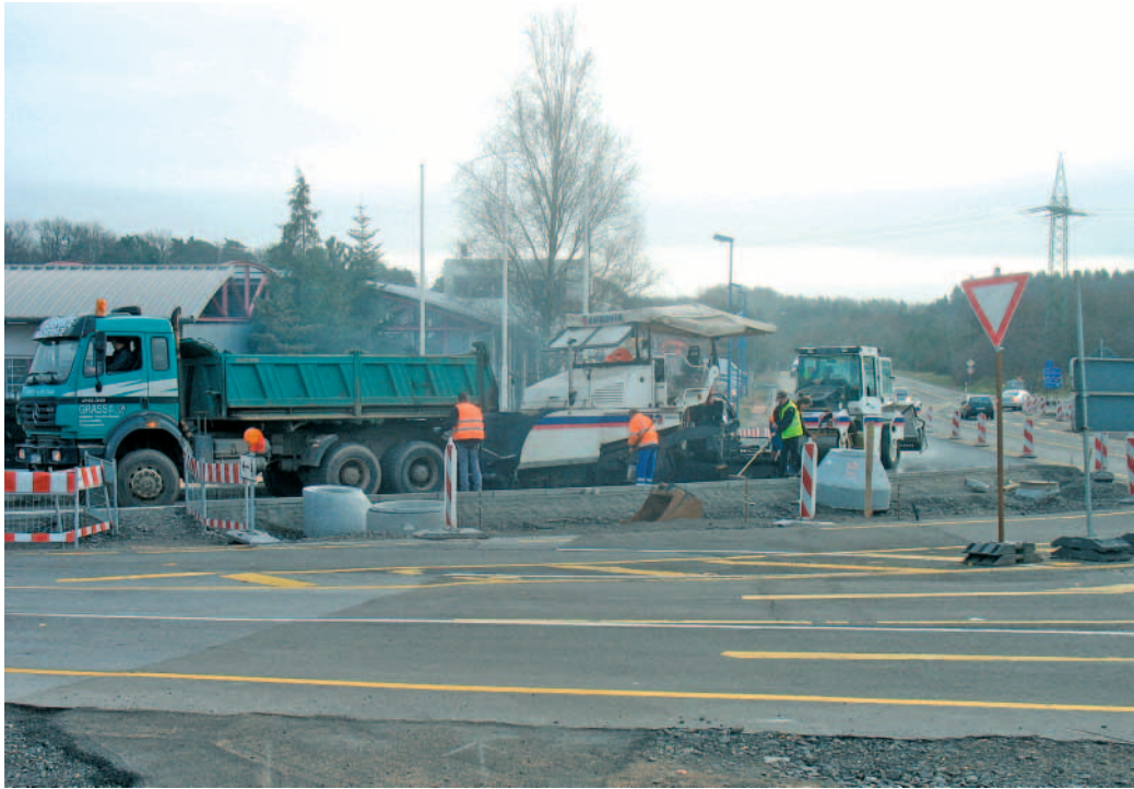
Gut voran gehen die Arbeiten am Doppelkreisel in der Oberstadt. Im Juni soll alles fertig sein.
