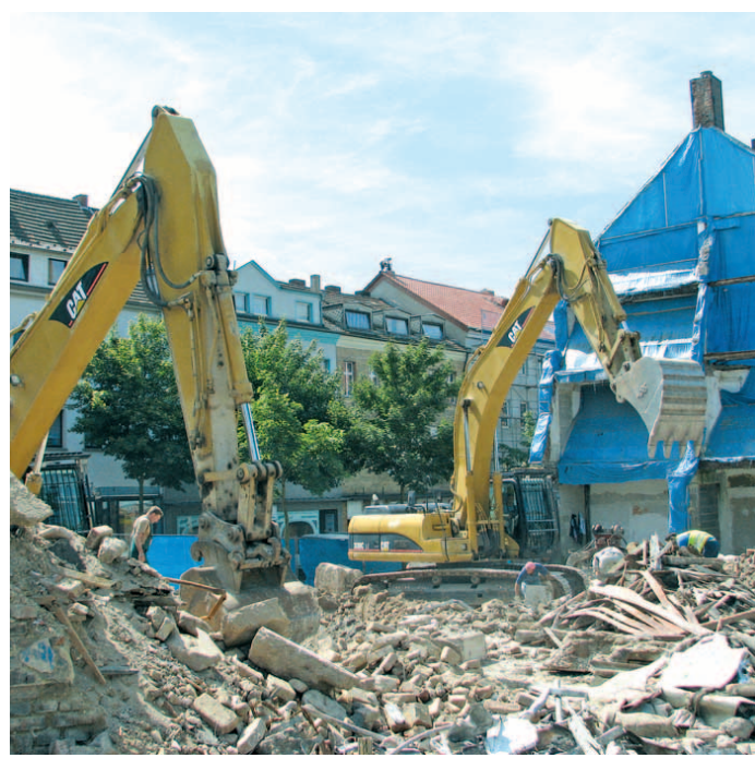
Die Mauerreste und Steine werden abgeräumt.
