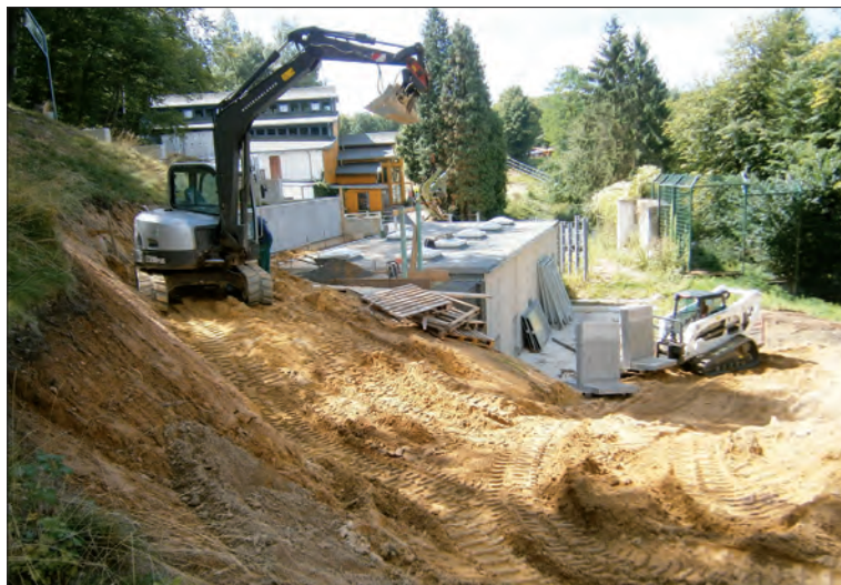
Baggerarbeiten am neuen Bärenghege Foto: Stadt Neunkirchen
