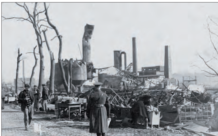
Verheerende Zerstörung in der Saarbrücker Straße Foto: Stadtarchiv NK
