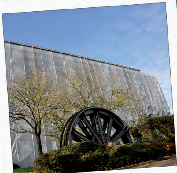
Rathaus gut gerüstet Neue Fassade für energetische Sanierung bis 2015.
