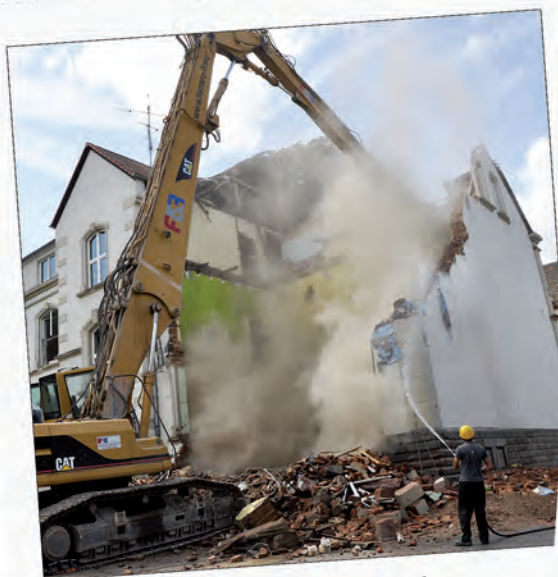
Abriss Grundschule Stadtpark Platz für die erste echte Ganztags- schule.
